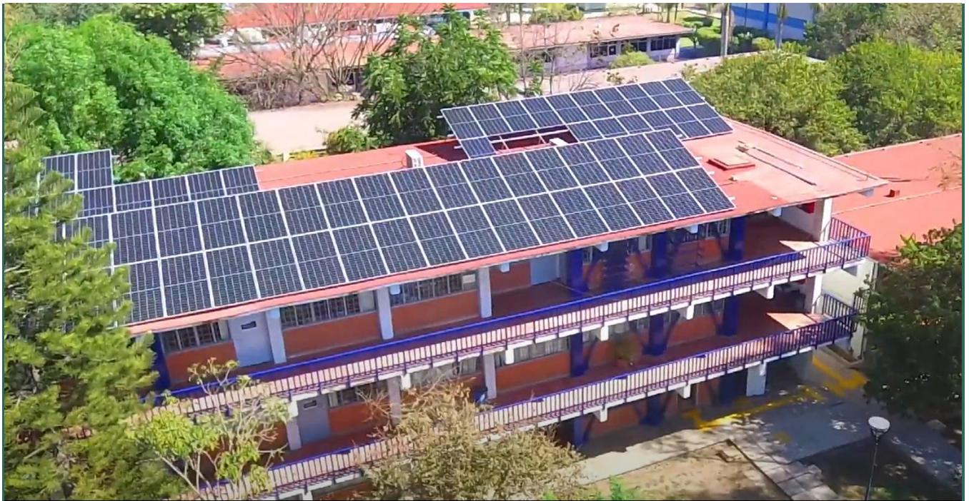
Sistema Fotovoltaico del CUCSUR, 320 kWp.
